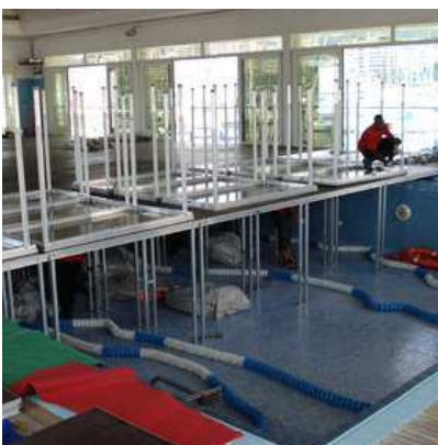
Secuencia de montaje de tarima en la piscina interior del RCNP.
